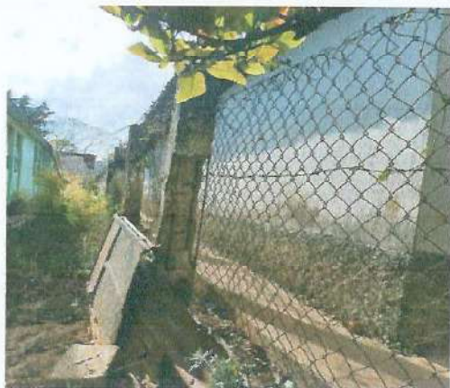
Foto 1: Instalación de malla en el perímetro del establecimiento.
