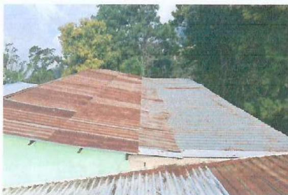
Foto 3: Cambio de entechado en 4 módulos.
