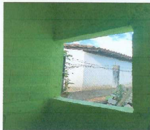
Foto 2: Instalación de ventanas en la cocina.
